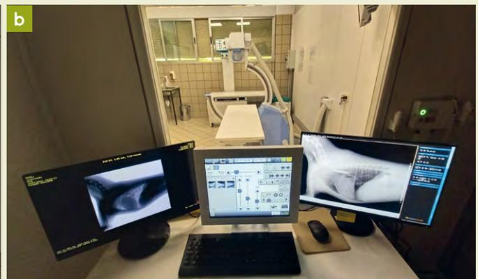
**FIGURA 1.32** Cabina con pareti, tetto e finestra in vetro piombato (a) e console di controllo e monitor situati all'interno della cabina (b), dove l'operatore può lavorare senza essere esposto alle radiazioni.
